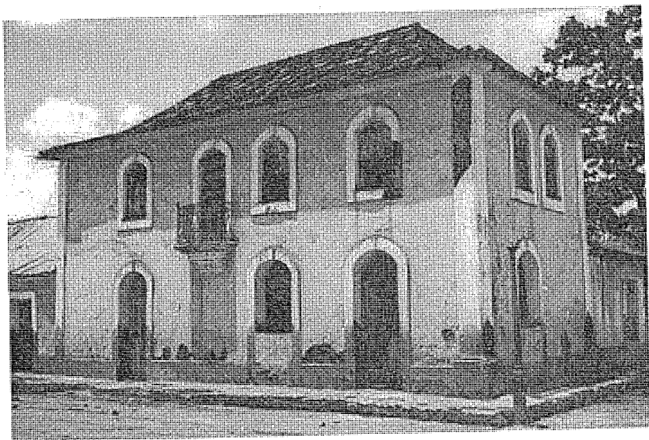
Edifício antigo para o MUSEU DO DONDO . Estava a ser restaurado em 1975, para instalação do Museu, da Biblioteca e do Arquivo locais.
